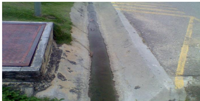
Figura 25. Canal de agua similar al propuesto para dirigir el agua de escorrentía
